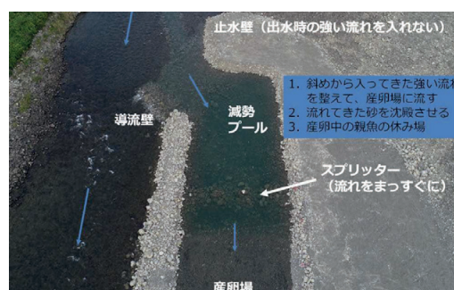
図5 水路タイプの産卵場の呑口に減勢プールを設けた事例
